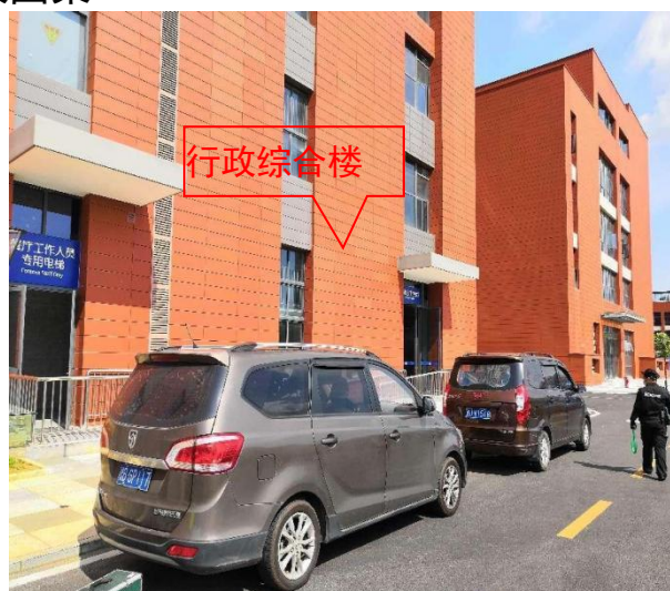
项目行政综合楼
