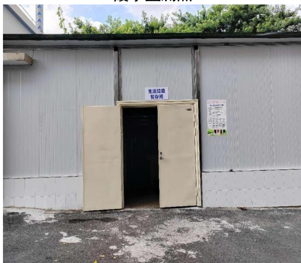
生活垃圾暂存间
