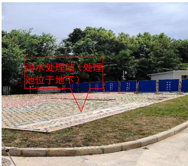
项目新建污水处理站
