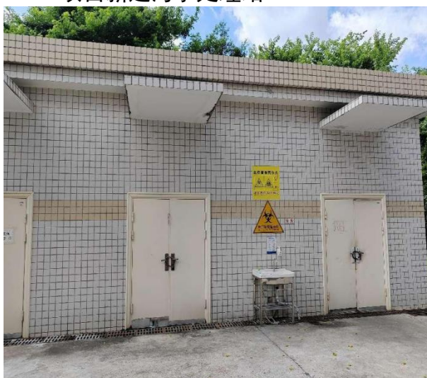
医疗废物暂存间
