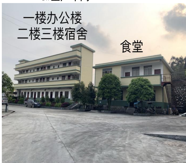
项目办公楼及食堂
