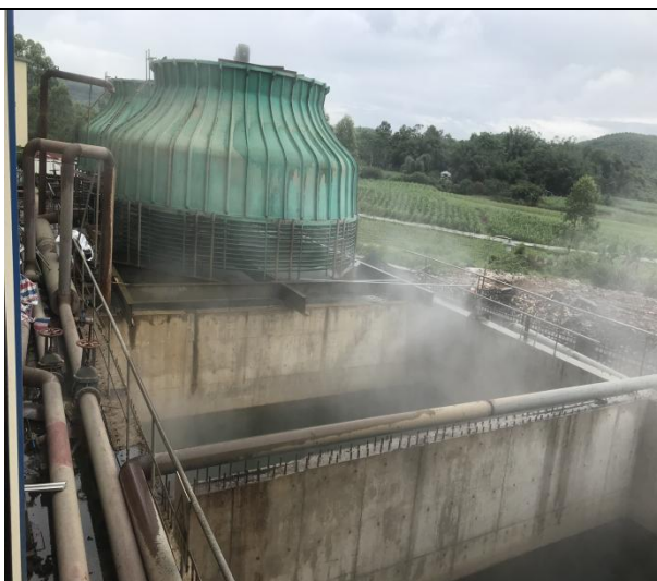
2#生产车间循环水池
