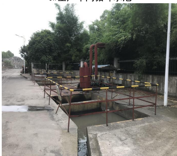
2#初期雨水收集池
