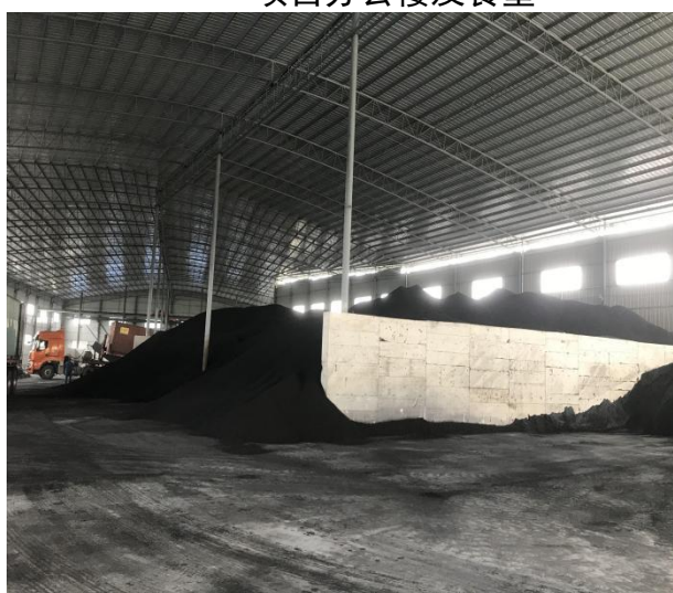
2#封闭的原料堆场
