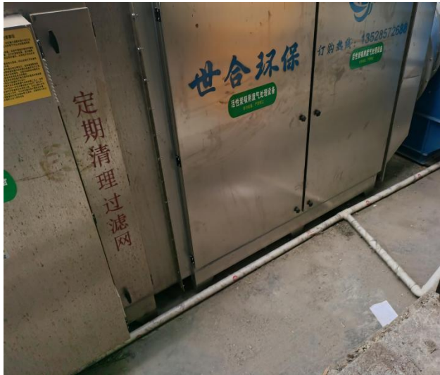
热压、涂胶工序废气处理设施活性炭吸附
