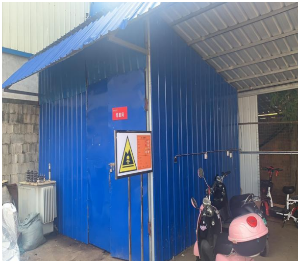
危险废物暂存间
