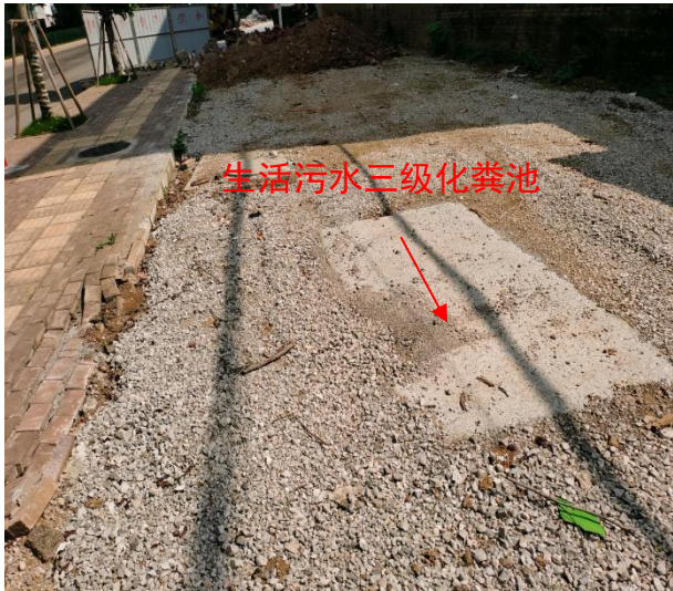
生活污水三级化粪池
