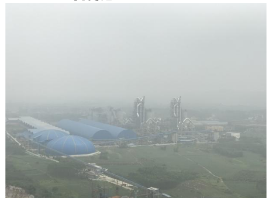
西南面广西合山虎鹰建材有限公司水泥熟料生产厂区
