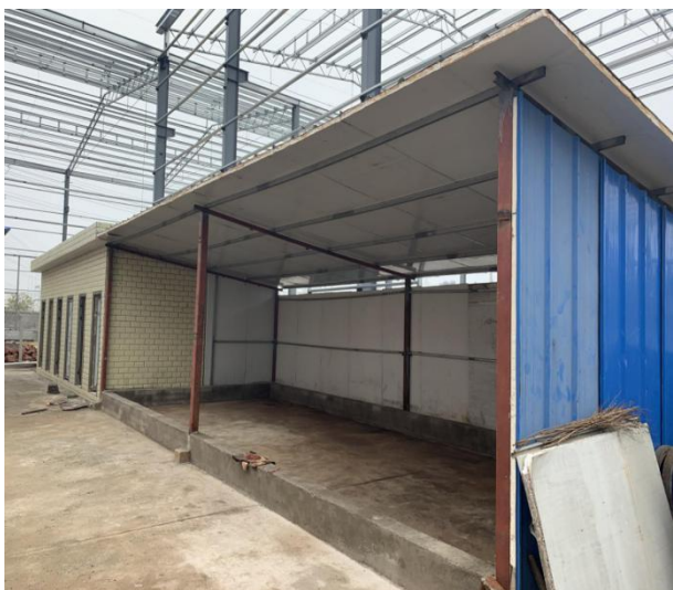
铁屑、边角料等固体废物堆放间
