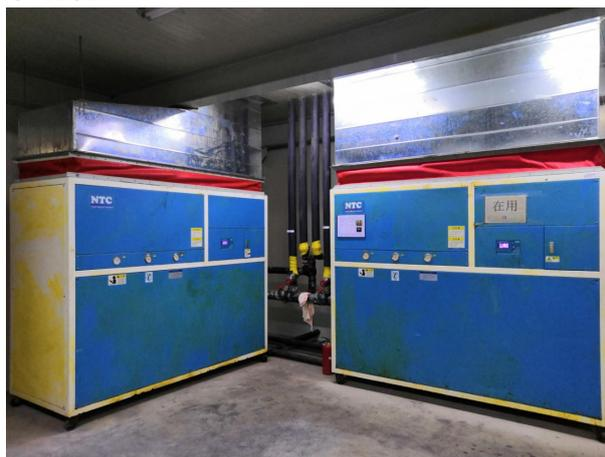
模温机水循环控温装置
