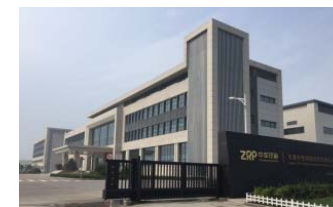
天津 2016新厂竣工
