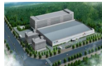
沈阳 2017新厂竣工
