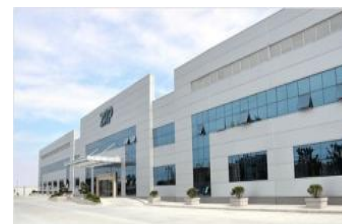
昆山 2014二期厂房竣工
